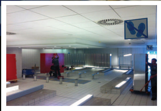
Lindenbad - Halle Westfalen Demontage
