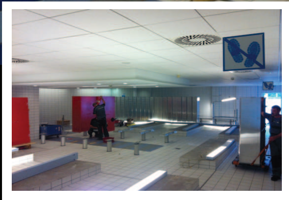
Lindenbad - Halle Westfalen Demontage
